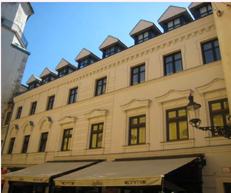
Rekonštrukcia fasád meštianskych domov v barbakane, Bratislava
